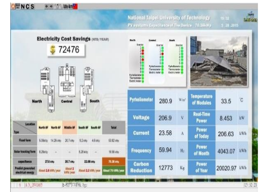
太陽光電管理系統 Photovoltaic management system
